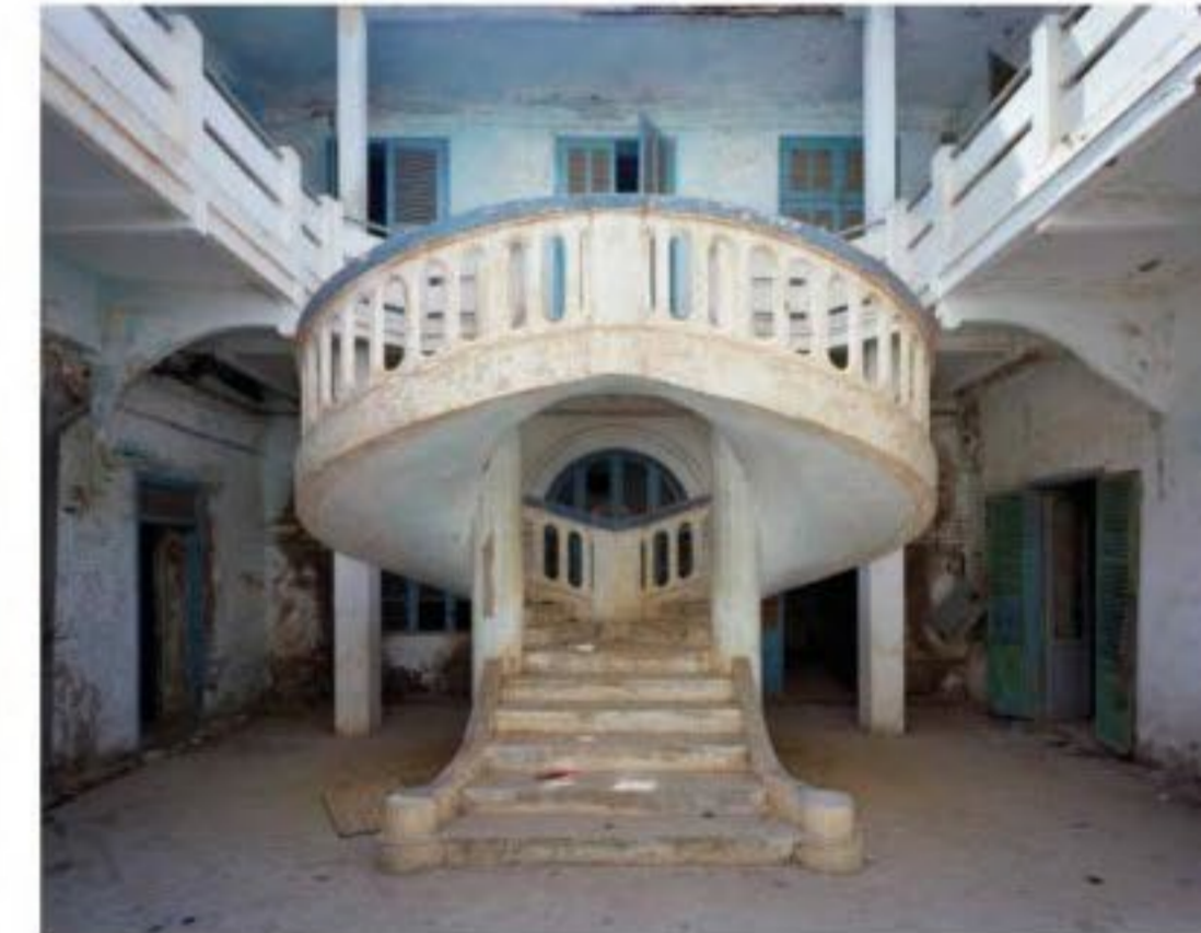
Къща, част от мрежата религиозни училища Sœurs de Saint-Joseph de Cluny , в зграда Сент Луи, Сенегал, построена през 1848 г.
